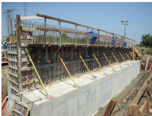
Bridge over Cação River
